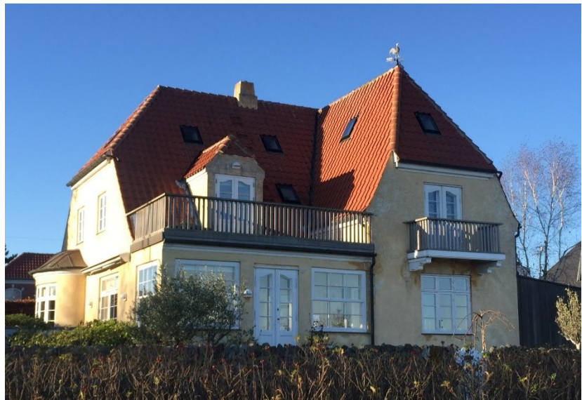
Billedet herover viser et hus, hvor der både er en tagterrasse (til venstre) og en altan (til højre).
