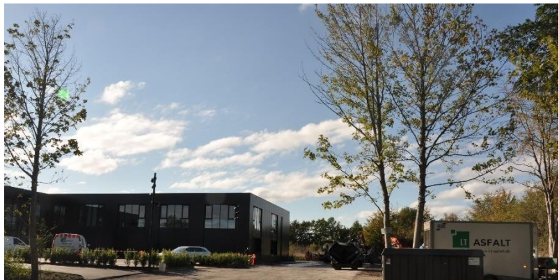
Bebyggelsen inden for lokalplanområdet fremstår med sort facadebeklædning.
