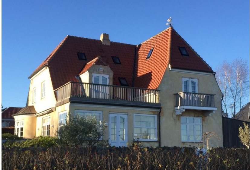
Billedet herover viser et hus, hvor der både er en tagterrasse (til venstre) og en altan (til højre).
