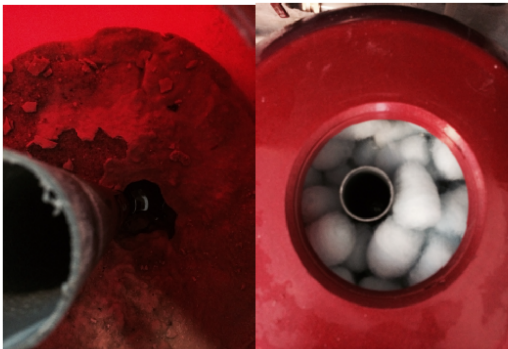
Filter hvor der ikke er blevet lavet rigtig bagskyl af filteret med sand.
